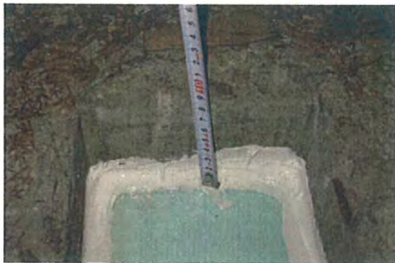
(底面スタイロ敷き・隙間をシーリング)
